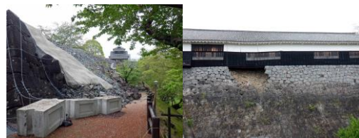
修復中の熊本城 (2022年4月)
